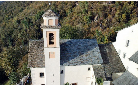
Il risanamento effettuato del tetto in piode
